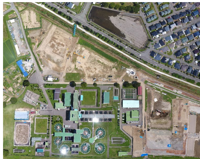
仁井田浄水場ドローン写真
