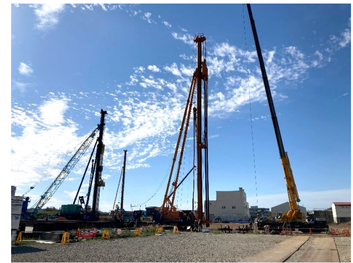
基礎工事施工状況
